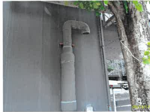
บำบัด Aerosol โดยกรองผ่านถ่าน Activated Carbon
