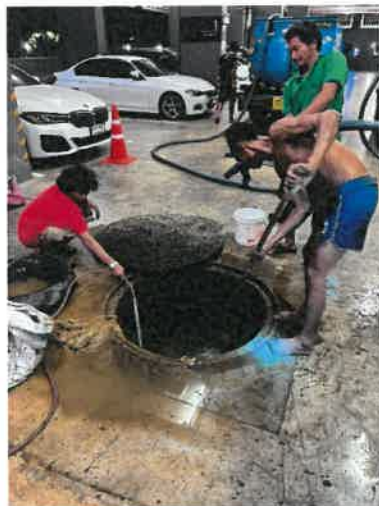
ตัดไขมัน และสูบล้างระบบบำบัดน้ำเสีย
